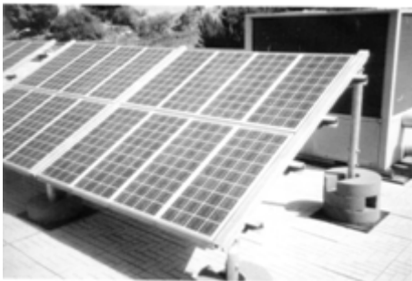
Esempio di struttura a cavalletto
